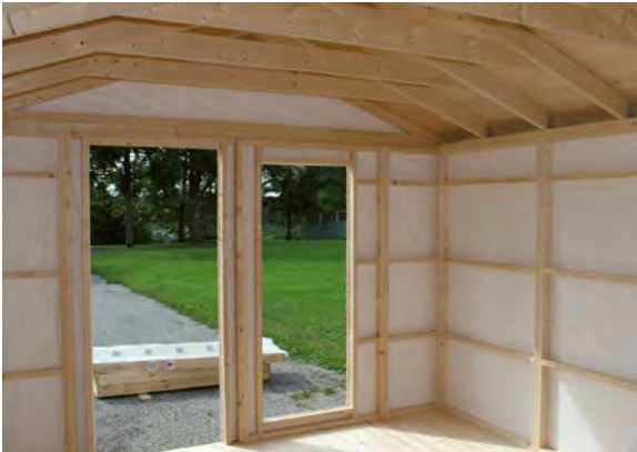
Innenansicht, Wände mit Windschutzfolie
