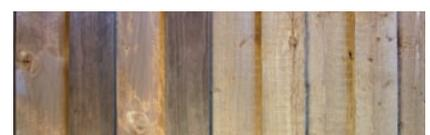
Ausführung Typ 28 mit Überdeckung; Bretter links gehobelt, rechts sägeroh.
